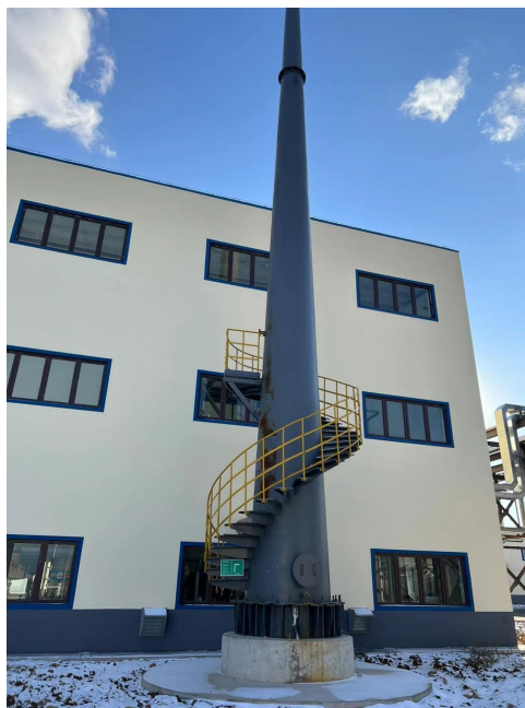
工艺废气处理车间 DA001 排气筒
